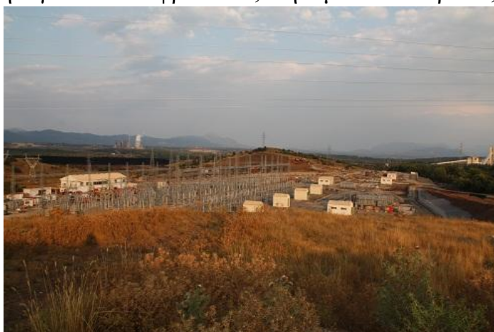
Το υπό κατασκευή ΚΥΤ. Η Αλλοίωση του τοπίου εμφανής
